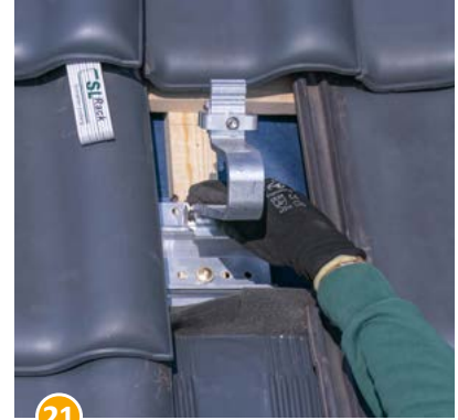
21 Dachhaken in Fuß einhängen.
