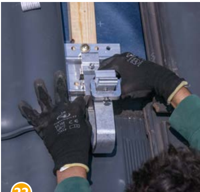
22 Einschnitt am Schaumstoffkeil um den Dachhaken...
