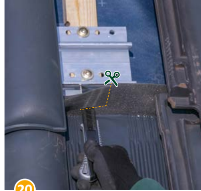
20 Schaumstoffkeil an der Position des Dachhakens mit einem L-Schnitt einschneiden.
