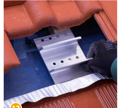
12 Fuß des Dachhakens auf dem Dachsparren ausrichten.
