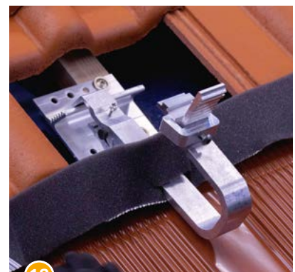
18 Einschnitt des Schaumstoffkeils um den Dachhaken stülpen.
