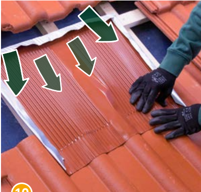
10 Dabei wieder darauf achten, dass sich im mittleren und oberen Bereich keine Wassersäcke bilden.
