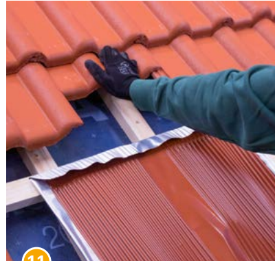
11 Dacheindeckung über Beta-Platte aufdecken.
