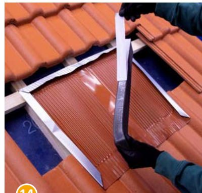
14 Schutzfolie des Klebestreifens auf der Unterseite des Schaumstoffkeils abziehen.
